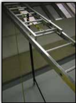
Figure 2-9. Sangle d'ancrage fixée à un « piton » mural et retenant l'échelle au 10 e échelon.
