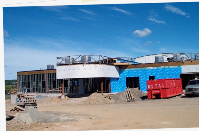
Chantier de Windsor Park
